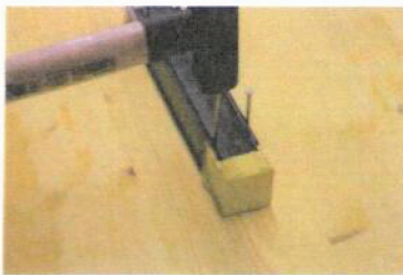
Schritt 3: Profil mit 60er Nagel mont.
